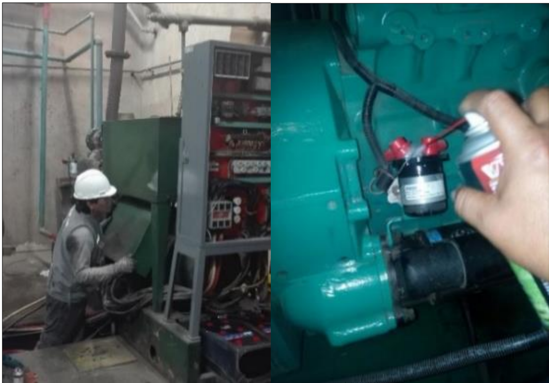
Figura 11. Gráfico del Servicio de Mantenimiento de Grupo Electrónico.
