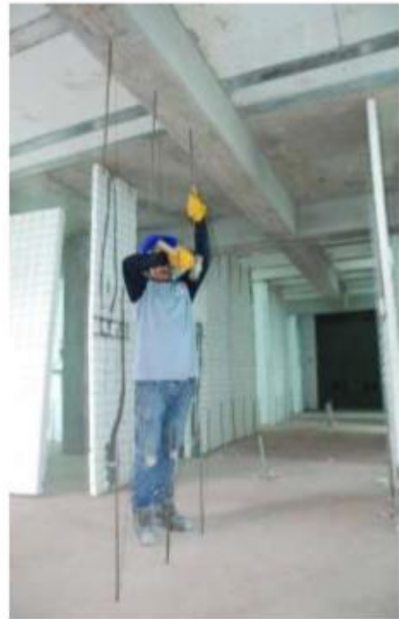
Figura 3. Instalación del EPS en obra. Fuente: Geinco S.A.C.
