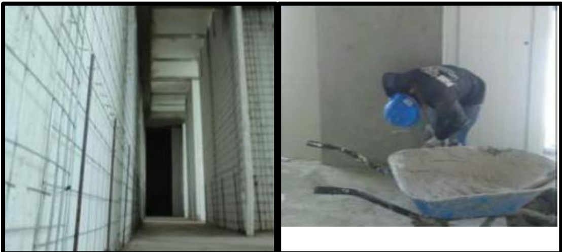
Figura 2. Instalación de los paneles. Fuente: Geinco S.A.
