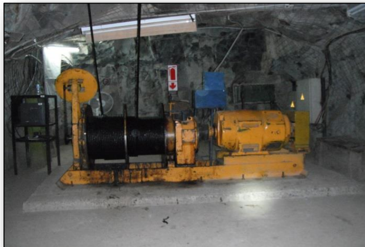
Winche electrico de Izaje 40HP (Ubicación: Unidad Orion)
