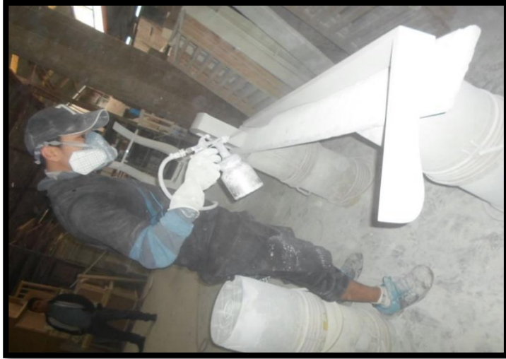
Figura 30. Aplicación de pintura con soplete
