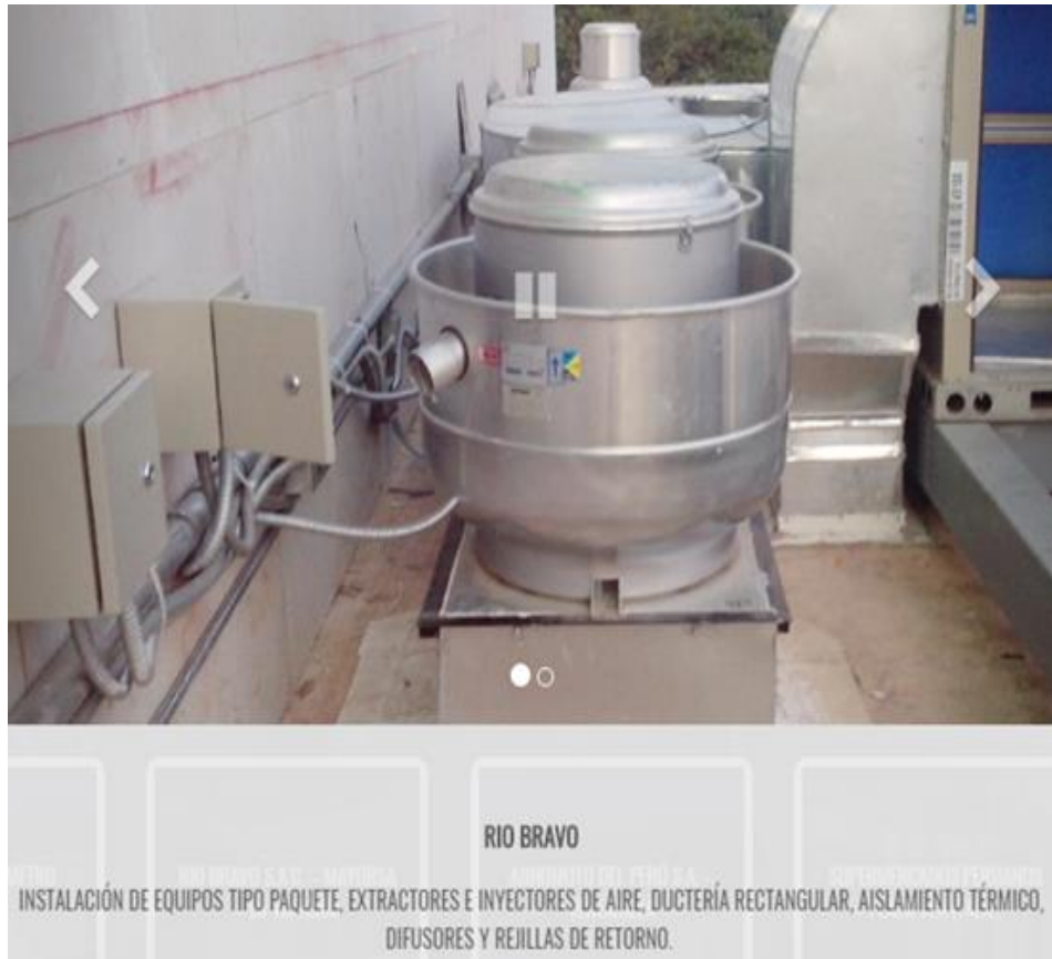
Anexo 8: Extractores instalados en la Obra Rio Bravo.
