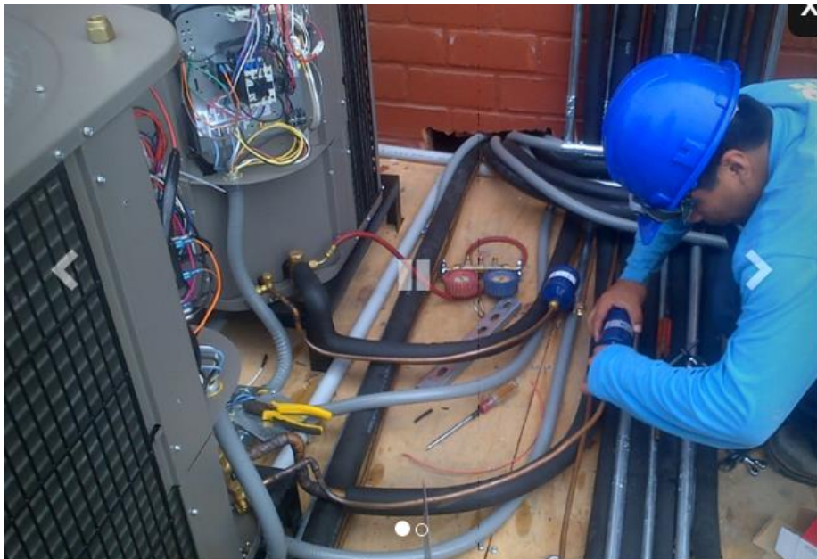
Anexo 7: Personal Técnico realizando instalaciones.
