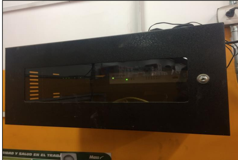
Figura 74. Equipos instalados y debidamente conectados.
