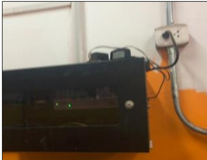
Figura 73. Conexión a la energía eléctrica.
