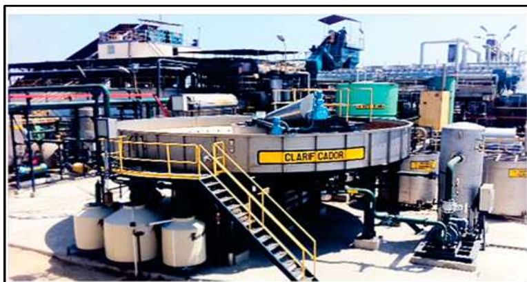
Figura N° 20: Montaje de Equipos en la empresa Edipesa S.A
