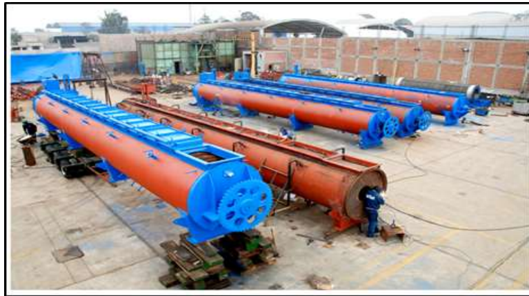
Figura N° 21: Instalaciones Mecánicas en la empresa Edipesa S.A
