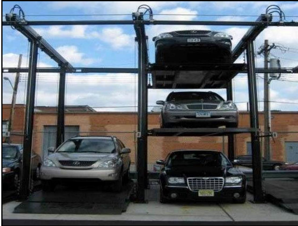
Figura 11. Sistema mecánico PS001. Fuente: Parking Solutions SAC (s.f.).
