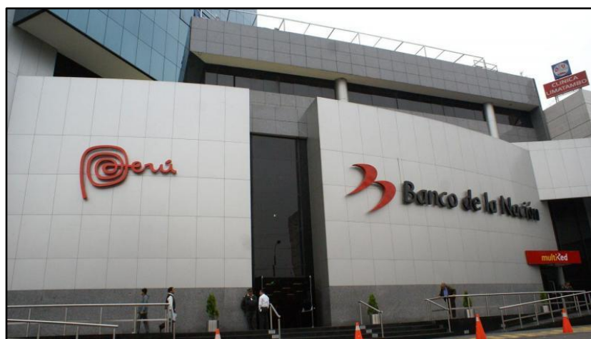
Figura 1. Sede principal del Banco de la Nación.
