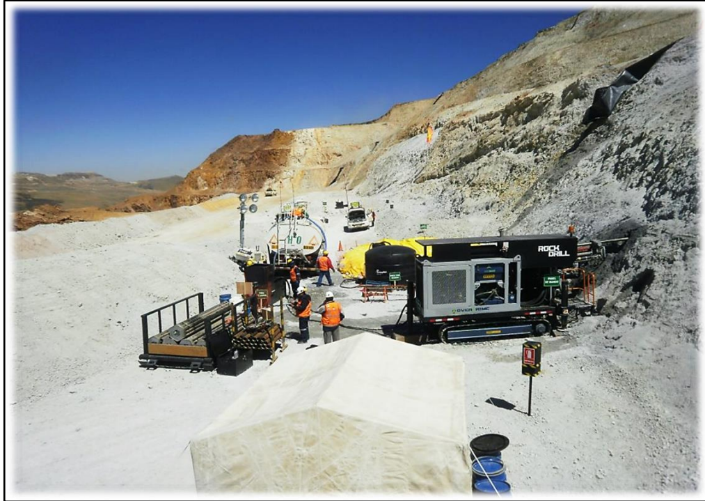
Figura 2. Máquina XRD80ST en trabajos de superficie.
