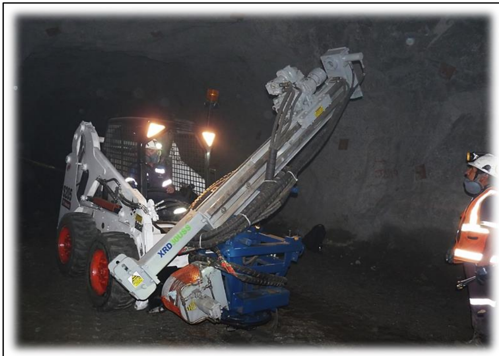
Figura 3. Máquina XRD90U en trabajos de subterráneo.
