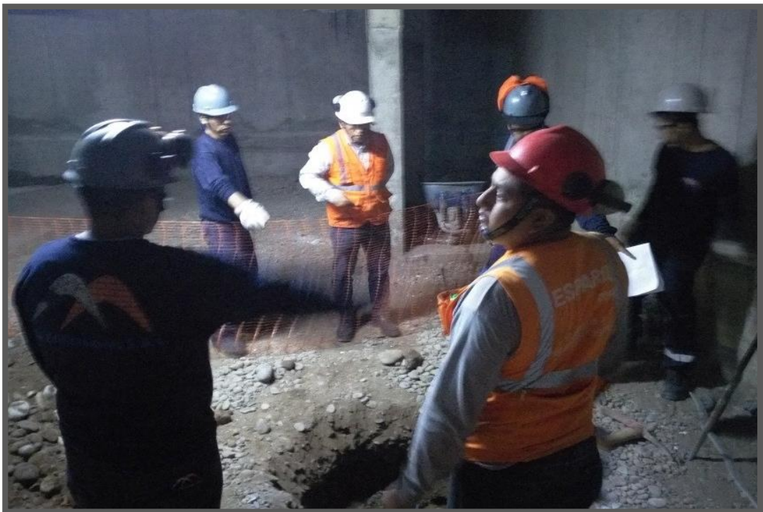
Fuente: Empresa A Y A Edificaciones SAC. Trabajos en Obra
