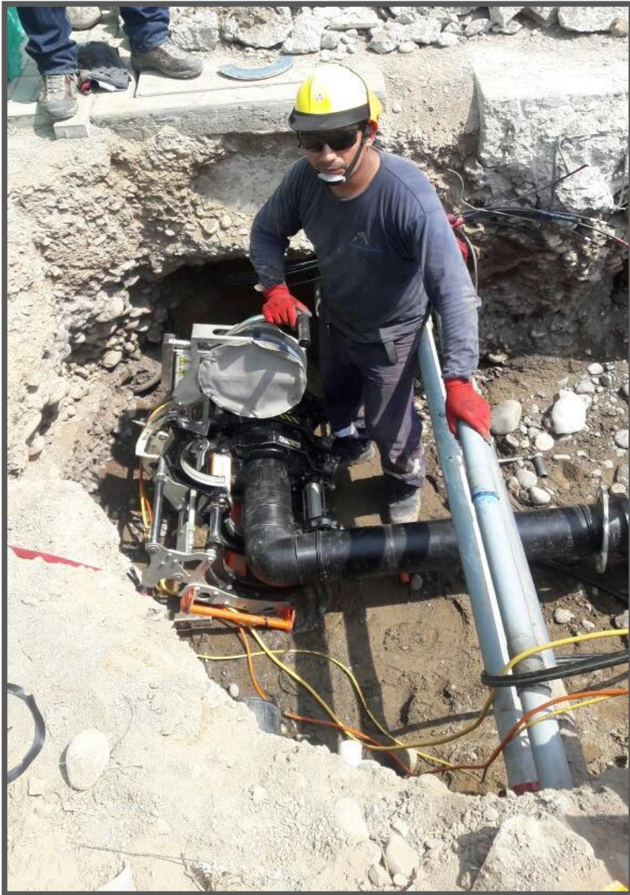
Fuente: Empresa A Y A Edificaciones SAC. Trabajos en Obra.
