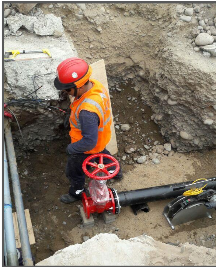
Fuente: Empresa A Y A Edificaciones SAC. Trabajos en Obra.
