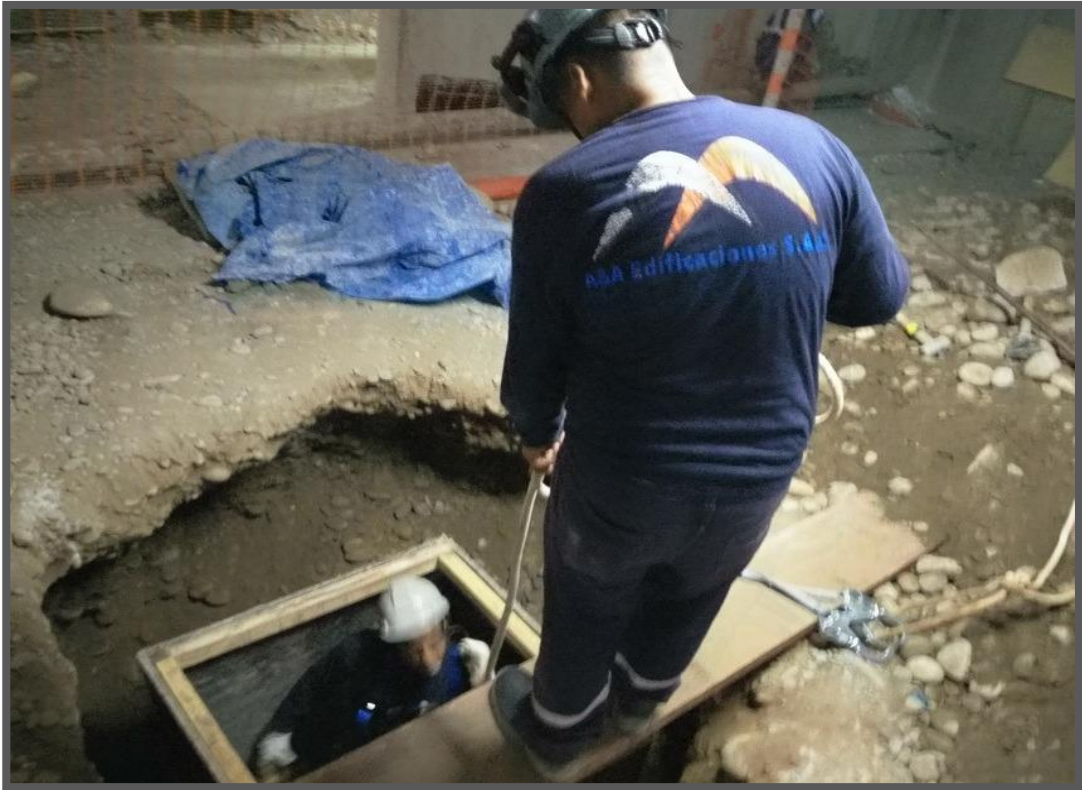
Fuente: Empresa A Y A Edificaciones SAC. Trabajos en Obra.
