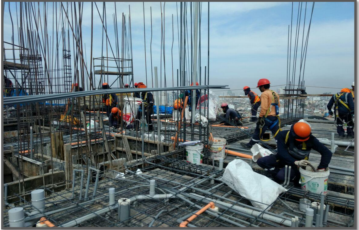
Fuente: Empresa A Y A Edificaciones SAC. Trabajos en Obra.
