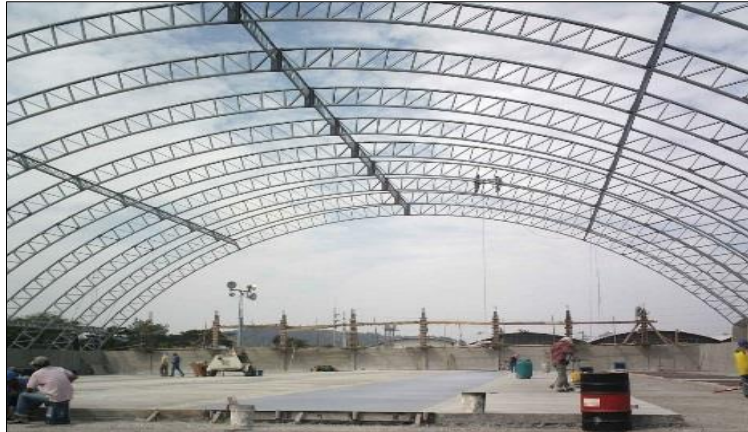
Figura 10. Fabricación y montaje de estructuras metálicas.
